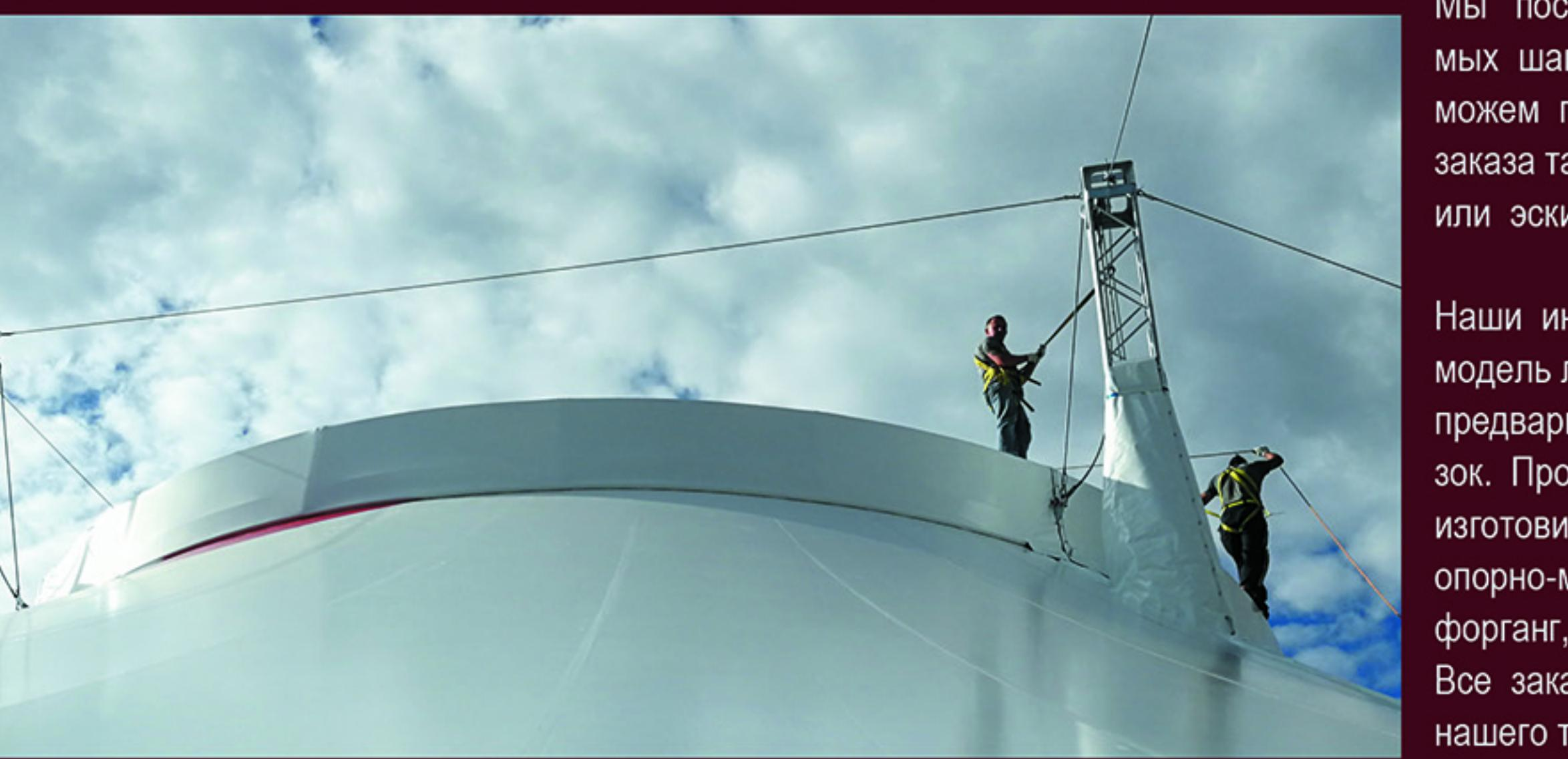
Металлоконструкции шапито изготавливаем из облегченных быстро-монтируемых стальных ферм и мачт. Зрительный зал цирка шапито адаптирован под конкретную конструкцию купола и учитывает пожелания заказчика. Полы – универсальные износостойкие панели. Сиденья - цельнопластиковые или раскладные кресла. При необходимости, поставляем и мягкие кресла для ВИП-зоны. Барьер манежа, конструкция форганга для артистов изготавливаются с учётом ваших пожеланий.
