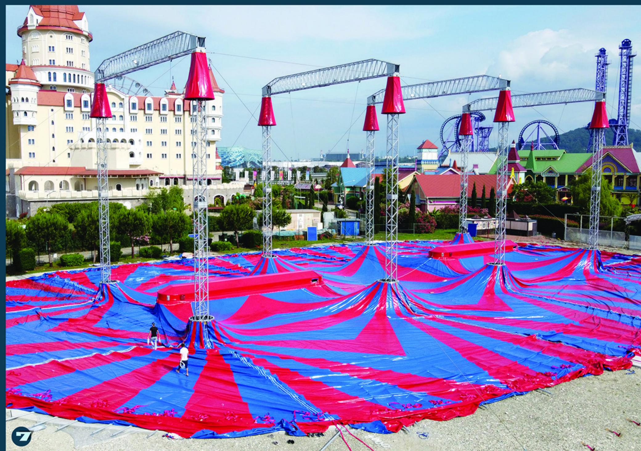
Весной 2020г мы реализовали беспрецедентный по масштабам проект по изготовлению и монтажу крупнейшего в России циркового шатра. Купол шатро 3400 м.кв., подвешенный за 2 основных кранца и 8 малых оголовков, состоит из 12-ти монтажных секций, которые стыкуются при сборке в цельное полотно путём шнуровки двухрядным петлевым верёвочным швом с дождевым клапаном.
