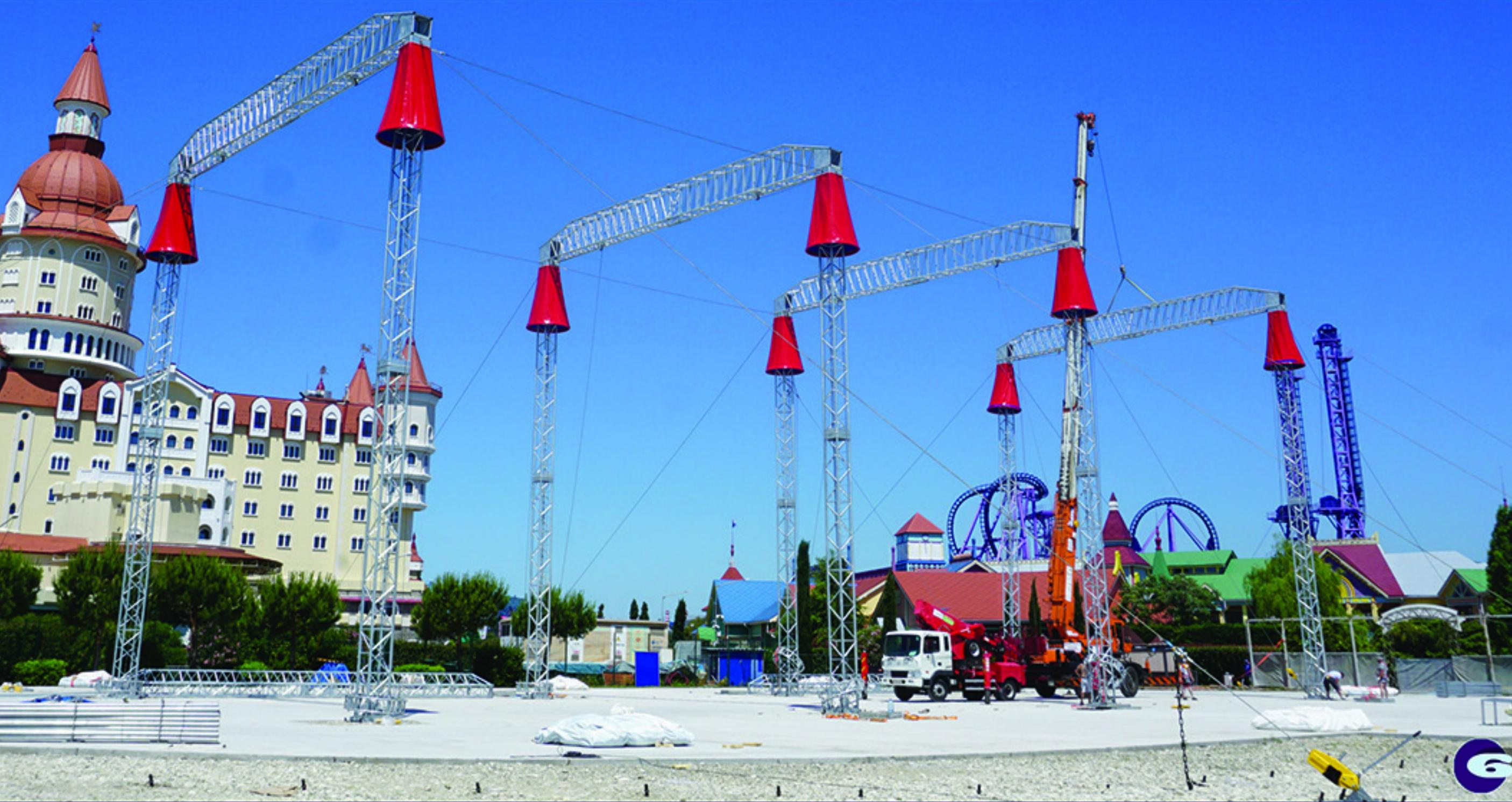
Весной 2020г мы реализовали беспрецедентный по масштабам проект по изготовлению и монтажу крупнейшего в России циркового шатра. Купол шапито 3400 м.кв., подвешенный за 2 основных кранца и 8 малых оголовков, состоит из 12-ти монтажных секций, которые стыкуются при сборке в цельное полотно путём шнуровки двухрядным петлевым верёвочным швом с дождевым клапаном.
