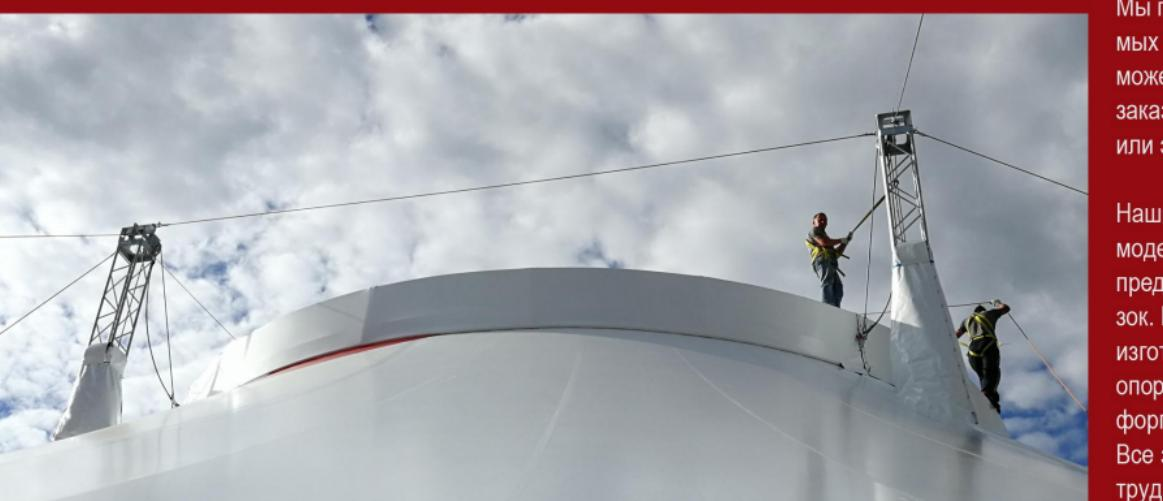
Металлоконструкции шапито изготавливаем из облегченных быстро-монтируемых стальных ферм и мачт. Зрительный зал цирка шапито адаптирован под конкретную конструкцию купола и учитывает пожелания заказчика. Полы – универсальные износостойкие панели. Сиденья - цельнопластиковые или раскладные кресла. При необходимости, поставляем и мягкие кресла для ВИП-зоны. Барьер манежа, конструкция форганга для артистов изготавливаются с учётом ваших пожеланий.
